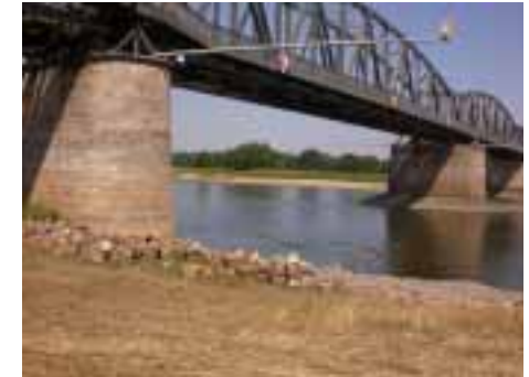
Eisenbahnbrücke Barby im August 2003
