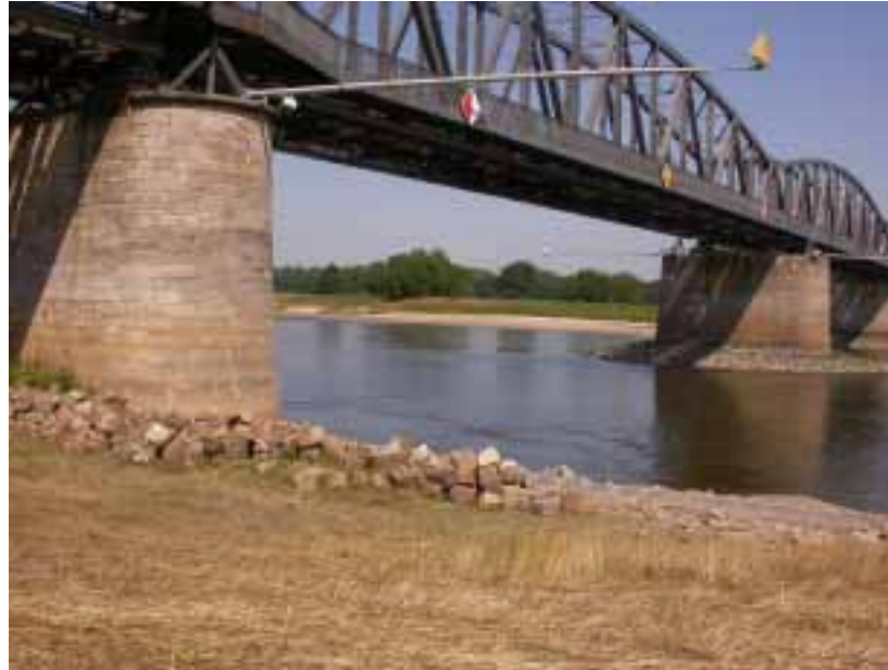
Eisenbahnbrücke Barby im August 2003
