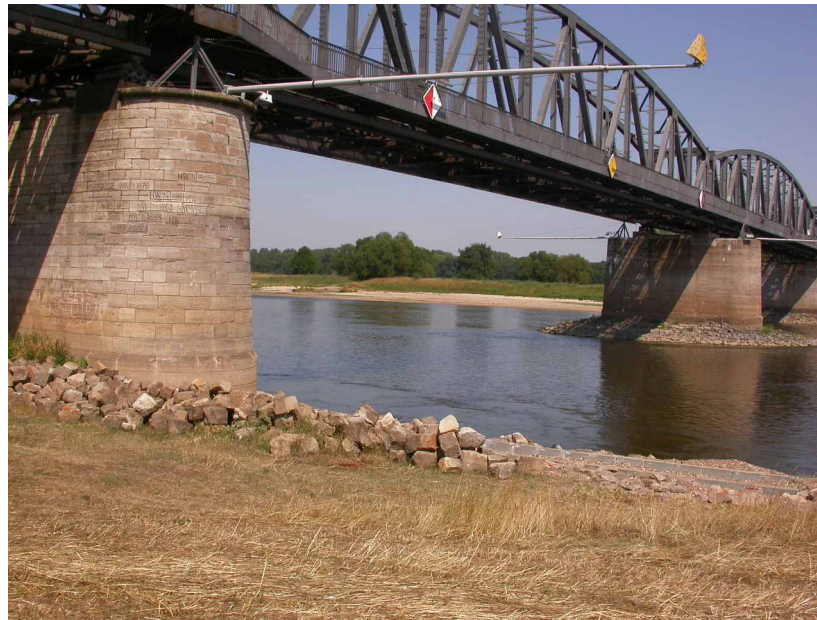
Eisenbahnbrücke Barby im August 2003
