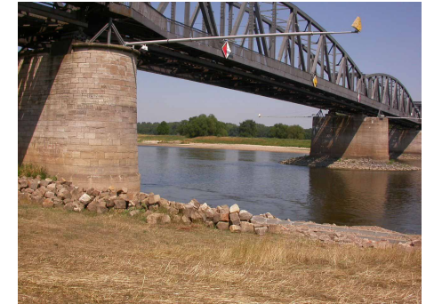
Eisenbahnbrücke Barby im August 2003
